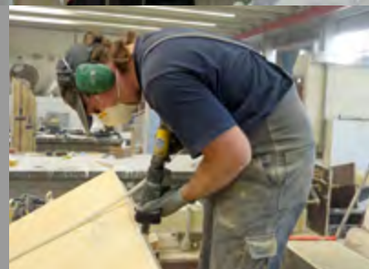
Justieren der Einbauteile vor der Betonage
