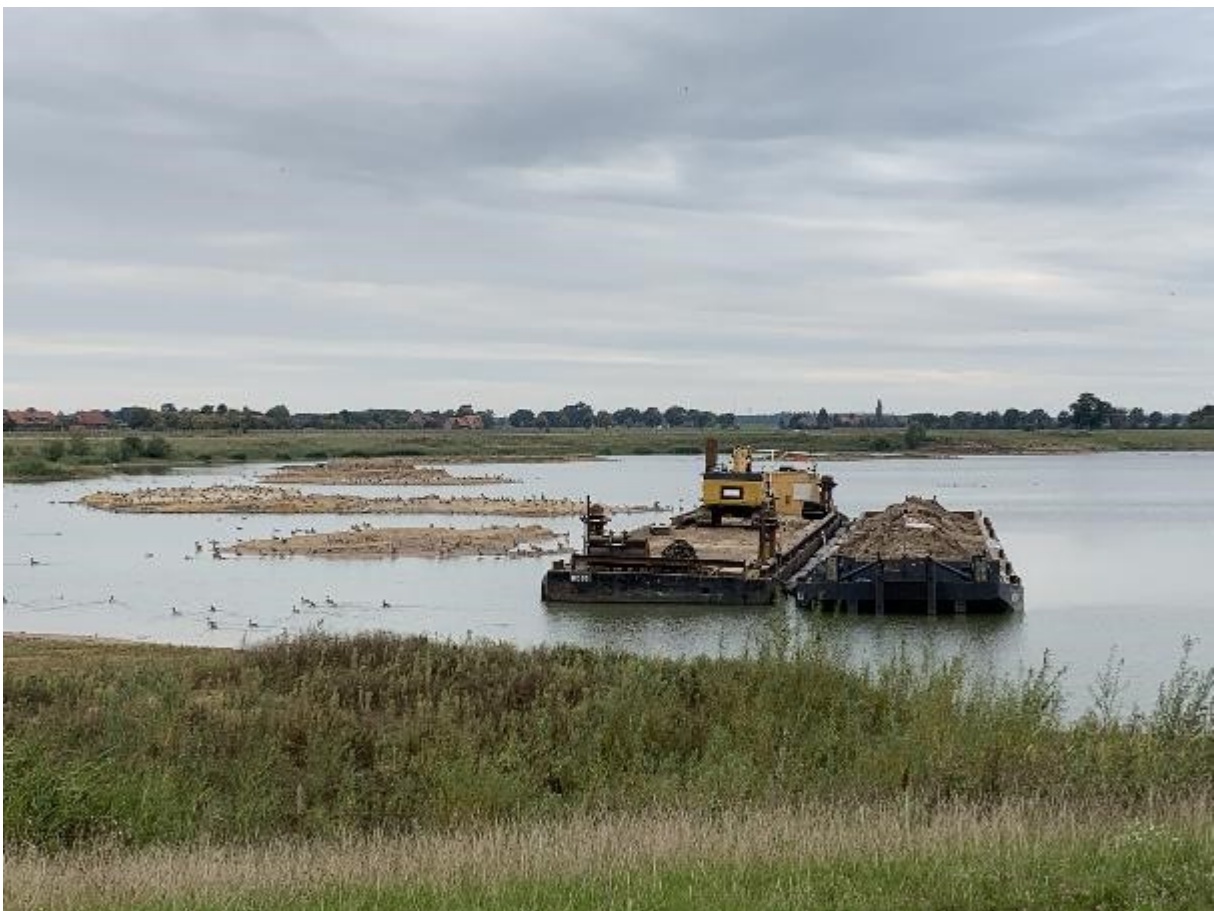
Abbildung 10: Arbeiten zur Teilverfüllung und Renaturierung des Baggersees Schweringen. (Foto: Günter Papenburg AG)
