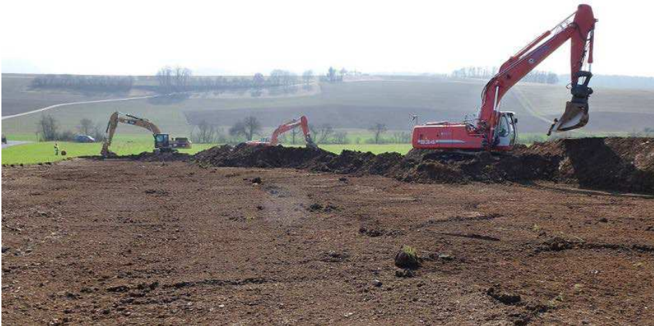
Abb. 5: Anlage eines Arbeitsstreifens, Quelle: OGE
