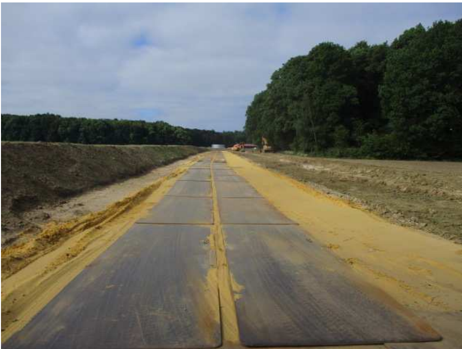
Abb. 6: Arbeitsstreifen mit Baustraße aus Stahlplatten auf Sandunterbau, Quelle: uventus
