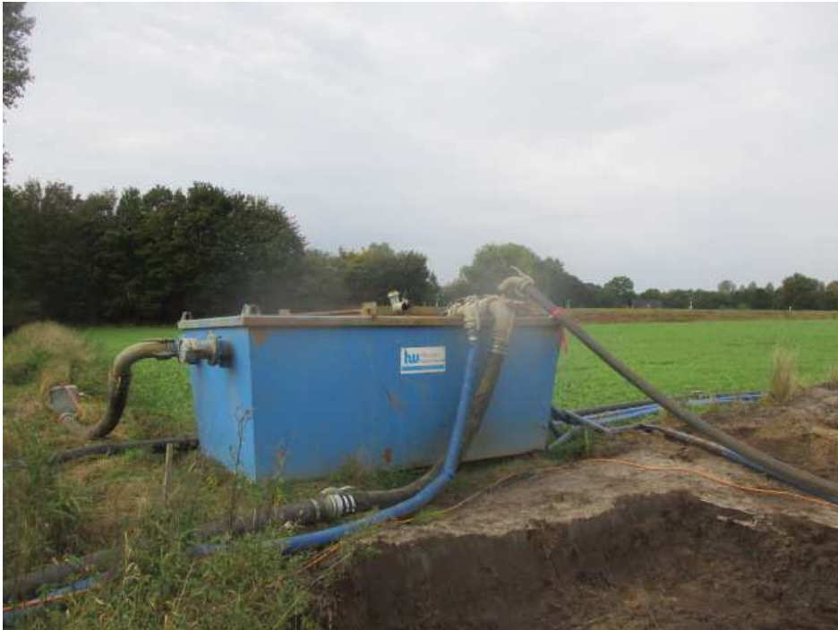
Abb. 9: Filterbecken für die Wasserhaltung, Quelle: uventus
