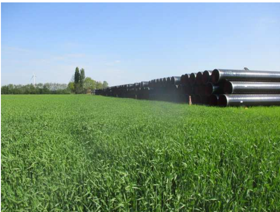
Abb. 8: Rohrlagerplatz, Quelle: uventus
