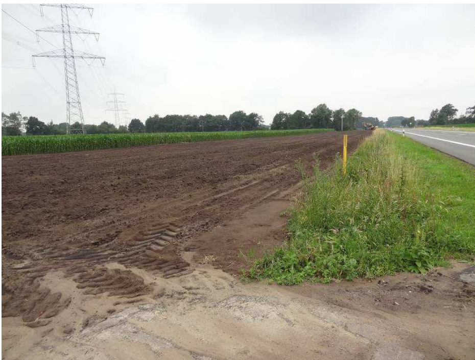
Abb. 14: Mit Mutterboden angedeckter Arbeitsstreifen, Quelle: uventus
