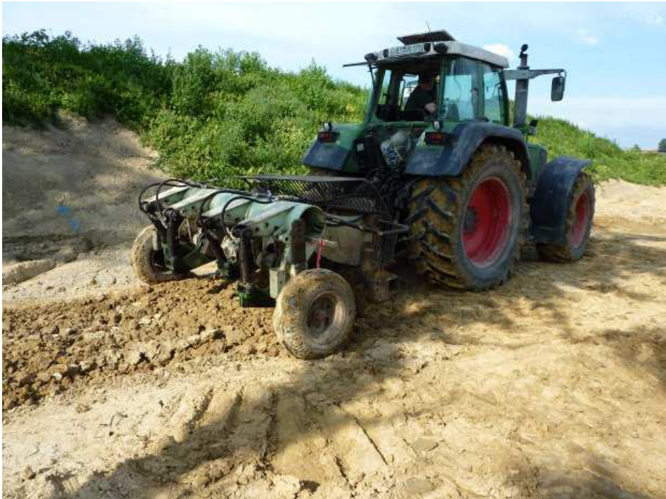
Abb. 13: Maßnahmen zur Bodenlockerung, Quelle: OGE
