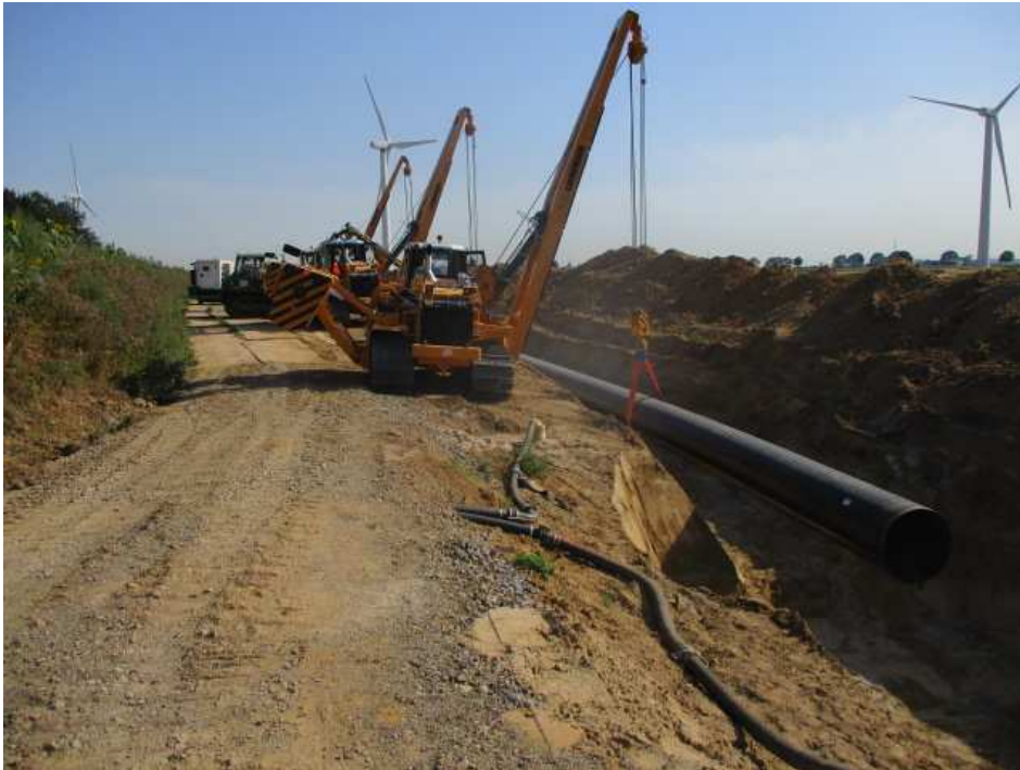
Abb. 11: Absenken des Rohrstrangs, Quelle: uventus
