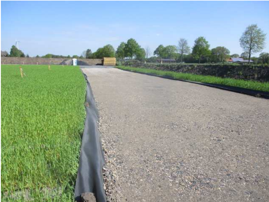
Abb. 7: Baustraße aus Schotter mit unterlegtem Vlies, Quelle: uventus
