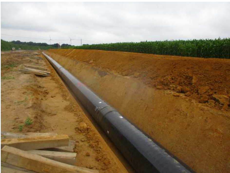
Abb. 12: In der Rohrgraben abgesenkter Rohrstrang, Quelle: uventus
