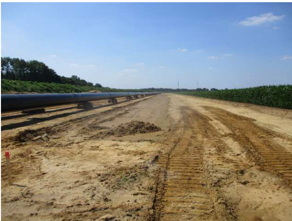
Abb. 10: Vormontierter Leitungsstrang, Quelle: uventus
