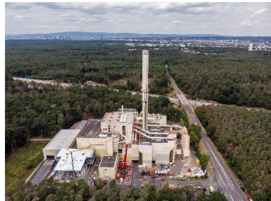
MHKW Offenbach mit Monoklärschlammverbrennung
