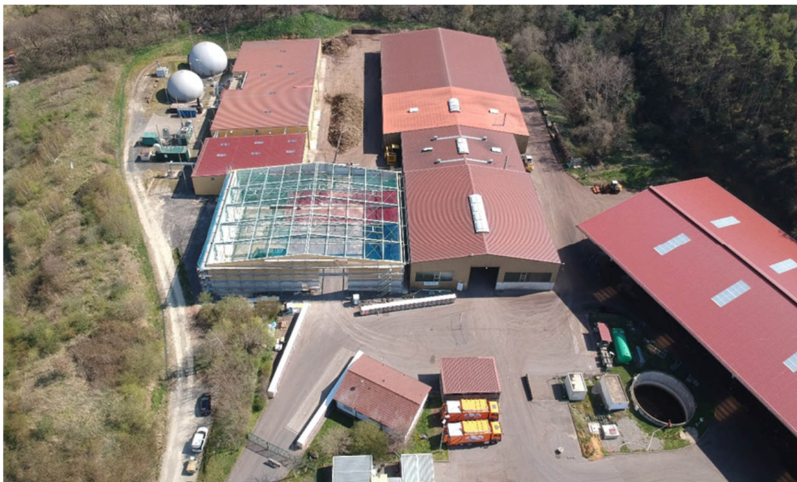
Biokompostierungs- und Vergärungsanlage in Lohfelden
