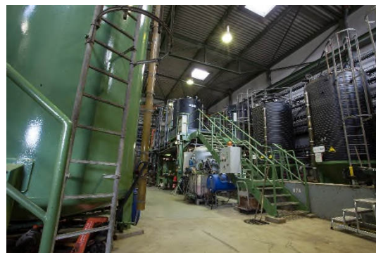
Halle der chemisch-physikalischen Behandlungsanlage HIM Kassel
