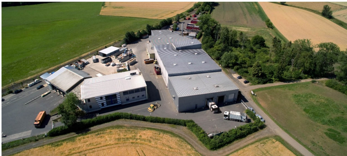
Mechanische Abfall-Aufbereitungsanlage in Echzell
