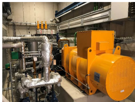
Dampfturbosatz der TREA 2
